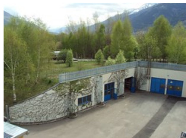
Centrale idroelettrica Rio Mulino 2
