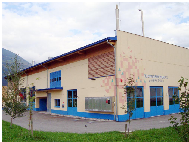
Centrale di teleriscaldamento Prato allo Stelvio
