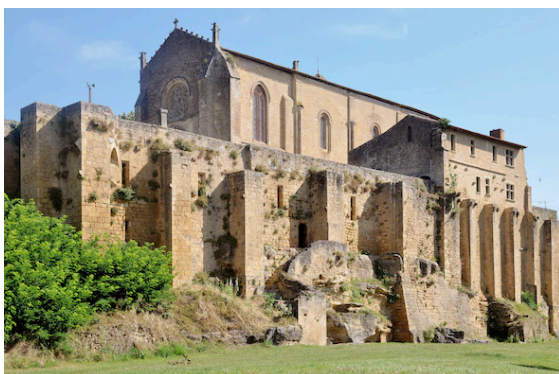
fig. 3. Posto su un affioramento calcareo, il complesso monastico di Saint-Sauveur si affaccia sull'area golenale della Garonna dall'alto dei remparts (fotografia di I. Agostini e D. Vannetiello).
